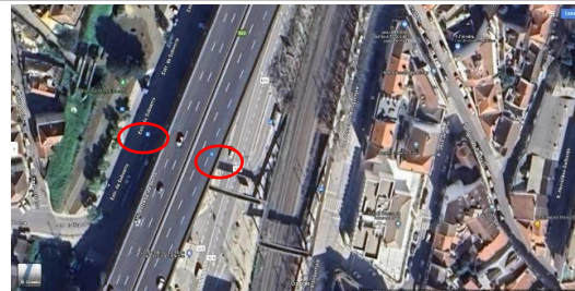
ALHANDRA (N10, junto ao viaduto da AE) e (N10, junto ao viaduto da AE)
